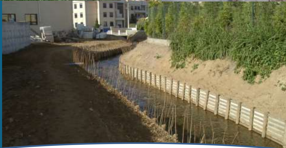
Aplicação de tela e estacas
