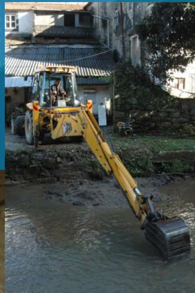
Desassoreamento mecânico
