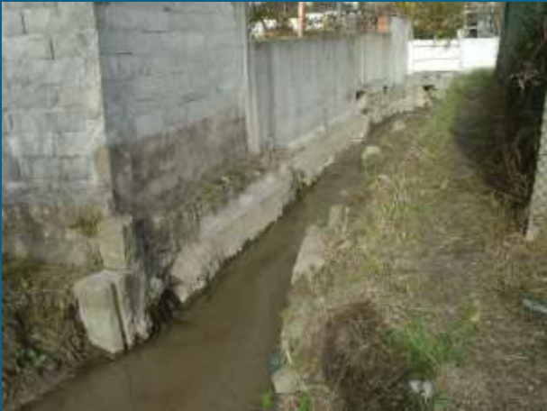
Construção nas margens
