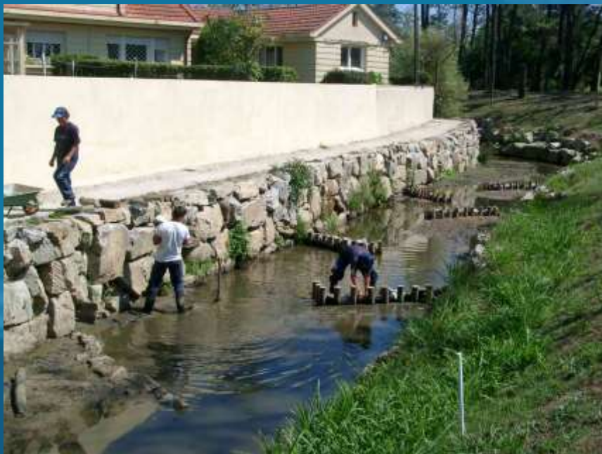
Aplicação de enrocamento
