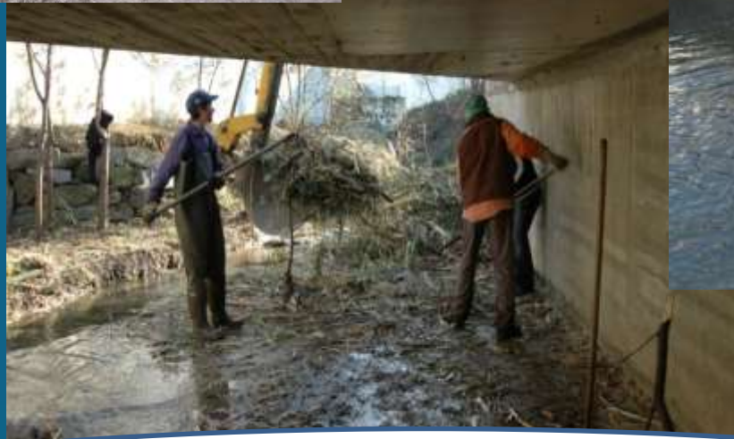
Desassoreamento manual
