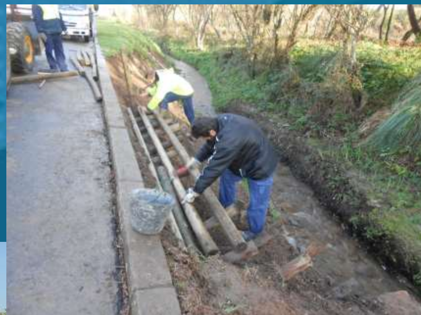
Aplicação de muro vivo ( cribwall )
