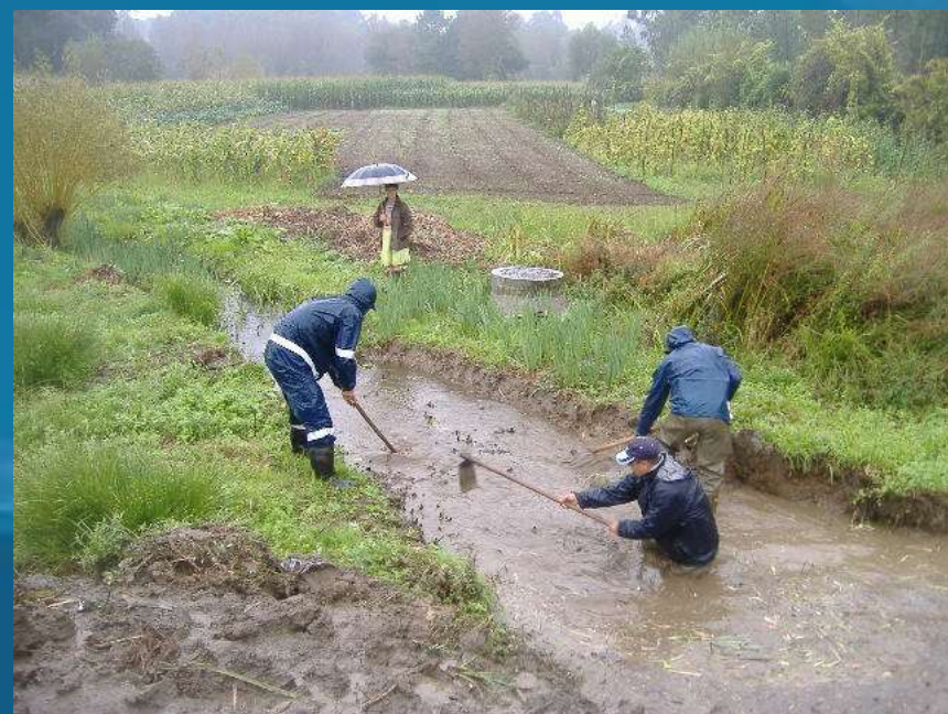
Desassoreamento manual
