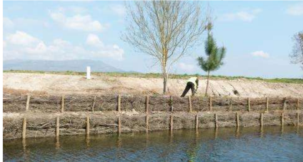
Construção de entrançados
